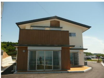
建物外観：北側
