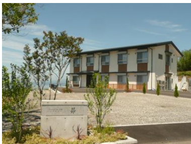
建物外観：玄関側
