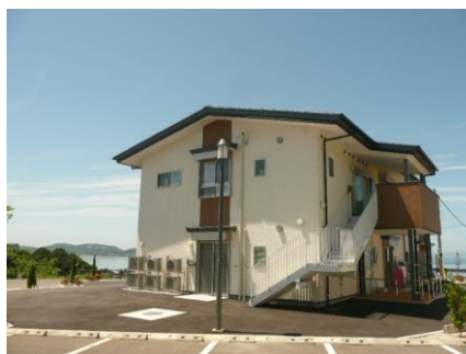
建物外観：南側
